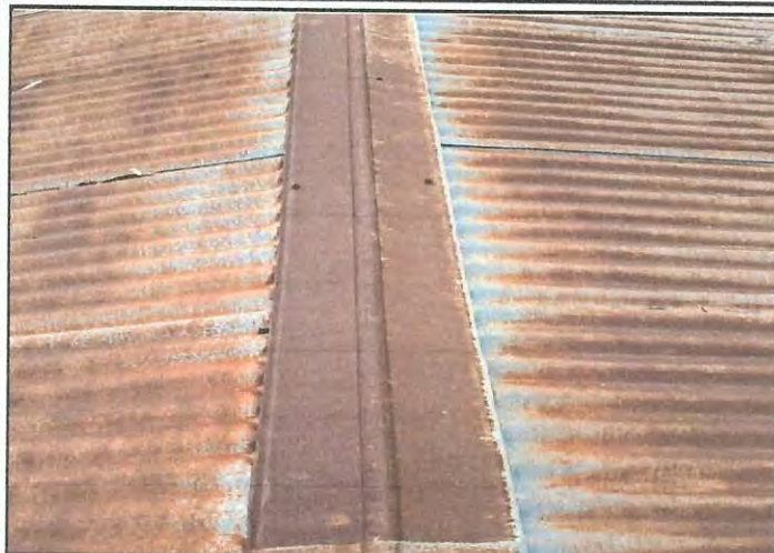
Foto1: Techo de aulas
