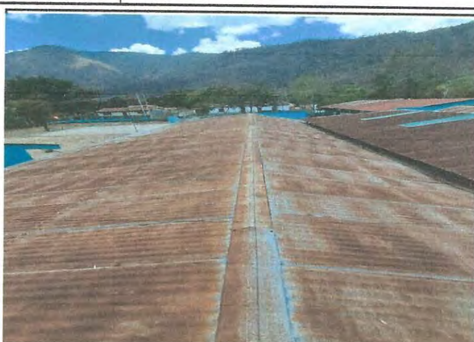
Foto 2: Techo de corredores
